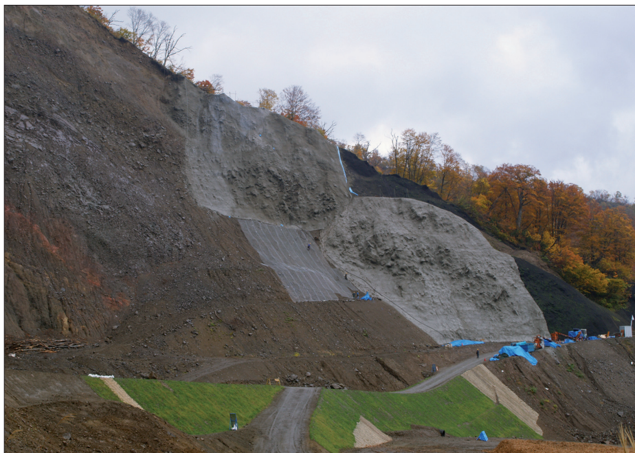
Obr. 2: Sanace sesuvu Nakajyo-gawa ze severu prefektury Nagano/Honšú. Sesuv vznikl podobně jako tisíce podobných po zemětřesení Tohoku v březnu 2011. Snímek z listopadu 2012. Foto: T. Pánek
