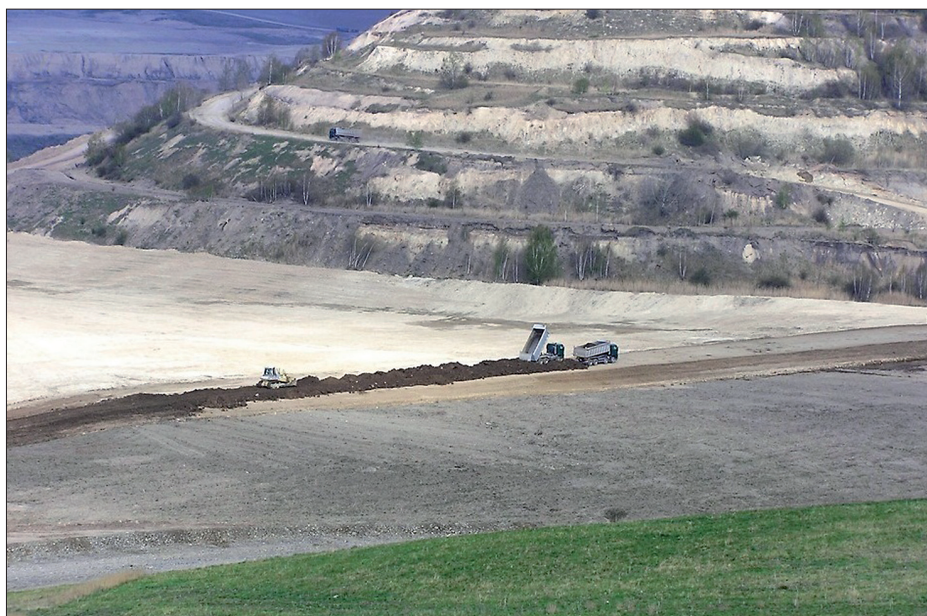
Těsnění zbytkové jámy pro budoucí jezero Most, květen 2007. Zdroj: Palivový kombinát Ústí
