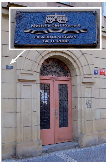
Povodeň v roce 2002 Karlín zcela zatopila, způsobila pád několika domů a život se zde k normálu vrátil několik let. Protipovodňová ochrana Karlína snad již nedopustí, aby případná povodeň dosáhla výšky hladiny Vltavy ze srpna 2002. Foto: P. Chromý
