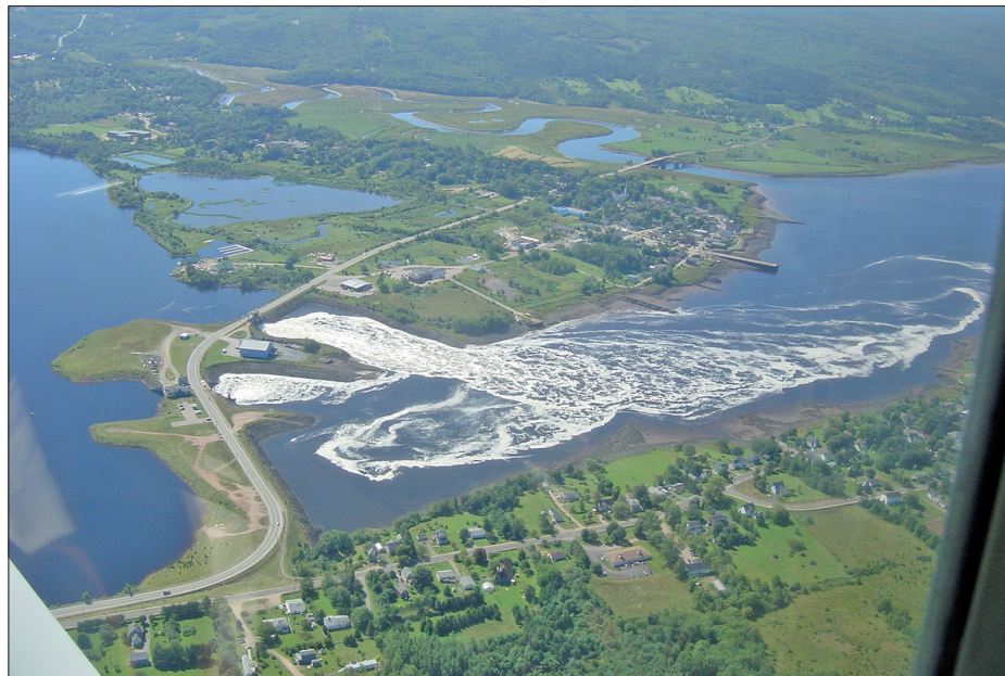
Obr. 2: Elektrárna Annapolis při přílivu. Průměrný rozdíl přílivu a odlivu v ústí řeky Annapolis do zálivu Fundy v Kanadě je 7,5 m. Zdroj: Google Earth, foto JD fla.
