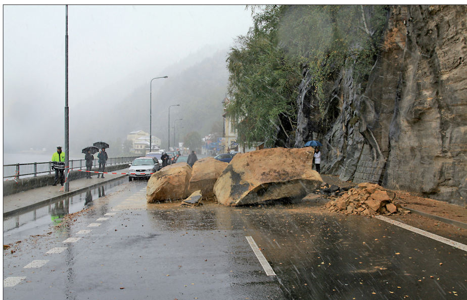
Obr. 2: Pískovcové bloky ze skalního řízení v roce 2009 zatarasily silnici podél Labe ve Hřensku. Největší z bloků dosahoval objemu 5,3 m 3 a hmotnosti přes 10 tun. Oproti situaci na obr. 1 je v tomto případě podstatně vyšší míra zranitelnosti společnosti. Foto: J. Zvelebil
